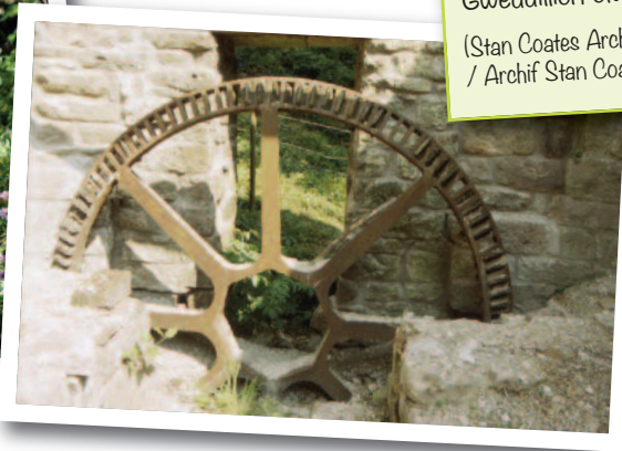
Remains of waterwheel at New Mills. Gweddillion olwyn ddŵr yn New Mills.
